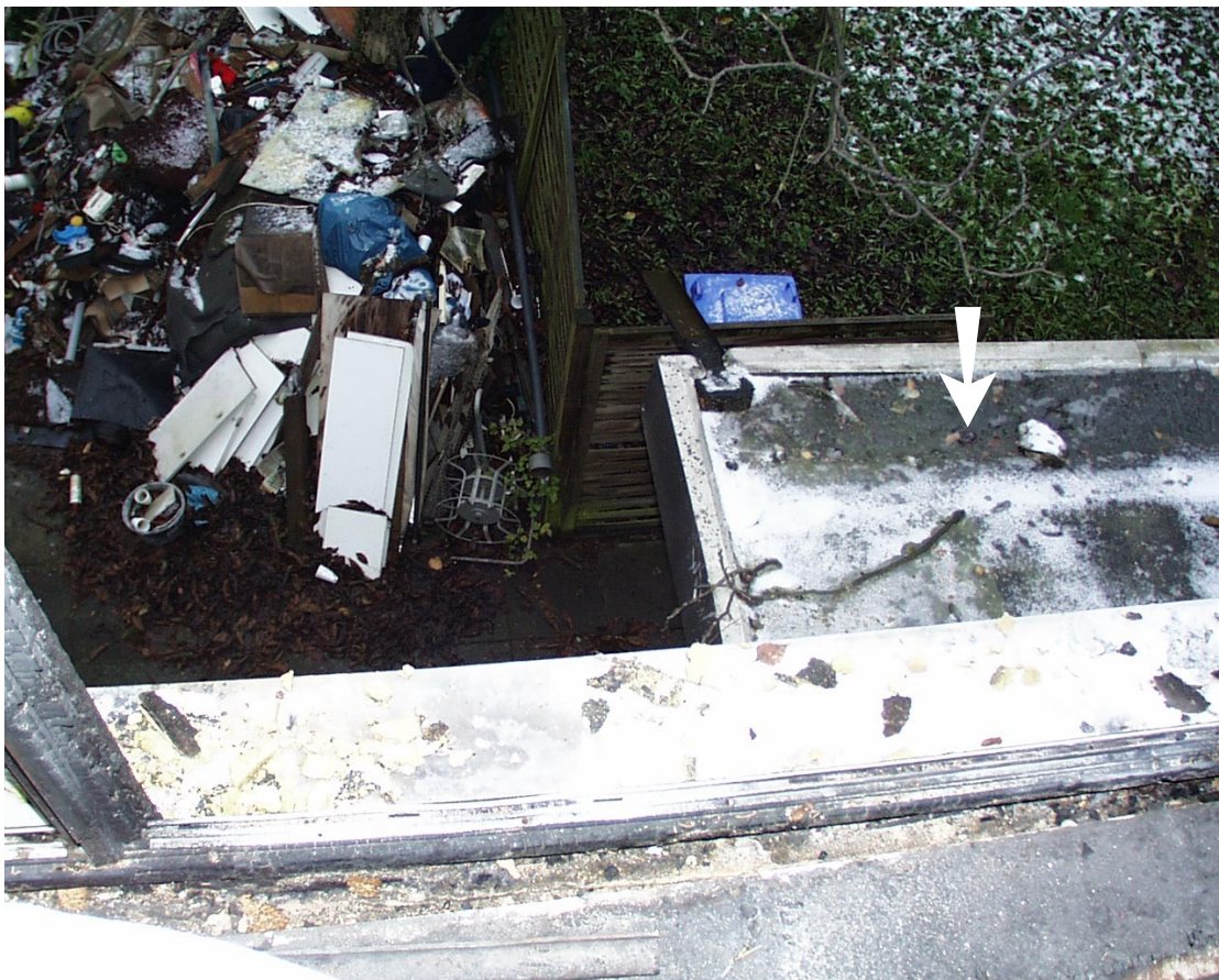
Bild 15 Vordach über dem Hauseingang, geeignet für Abstieg
