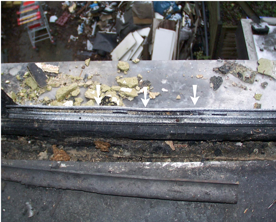
Bild 14 Thermische Verformung des Metalls
